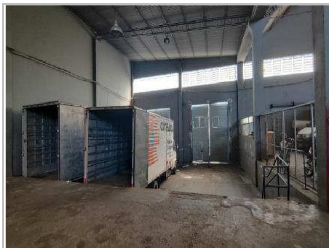
VISTA INTERNA DO GALPÃO (CARGA E DESCARGA)
