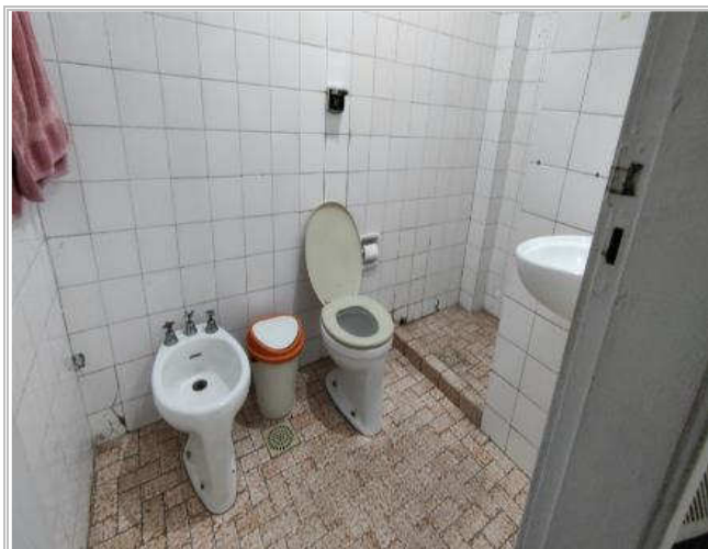
BANHEIRO DE FUNCIONÁRIOS (2º PAVIMENTO)
