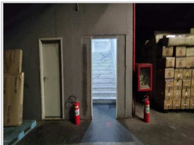
ACESSO AO PRÉDIO ADMINISTRATIVO POR DENTRO DO GALPÃO
