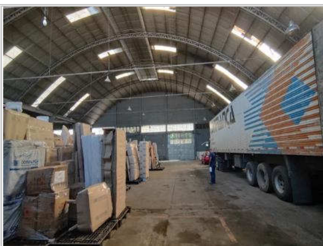
VISTA INTERNA DO GALPÃO (DEPÓSITO)
